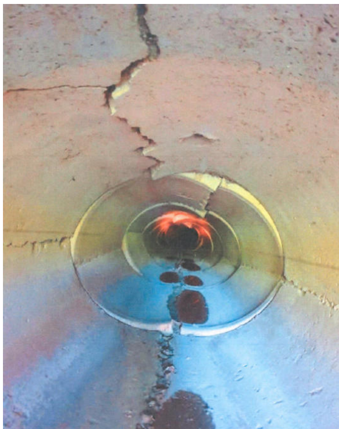
Fosso Piscinello – Cedimento della tubazione autoportante
